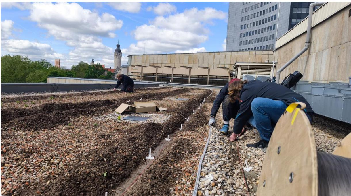
Abb.: Installation faseroptischer Messtechnik ins Gründachsubstrat vor der Bepflanzung (Foto: Ulf Trommler)
